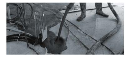
Agilia RAVOIRAGE Léger C-1004 / C-1006 / C-1008 sont des mortiers fluides allégés à base de ciment et de billes de polystyrène destinés à la réalisation de ravoirages fluides.
