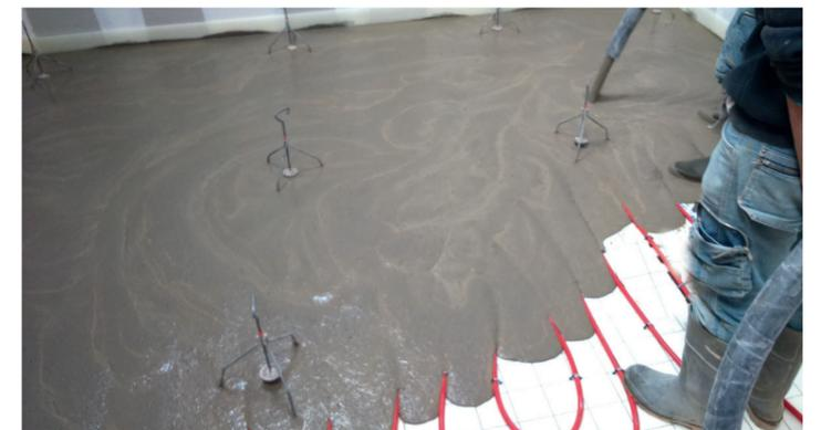
Agilia CHAPE THERMIC C-3000 / C-3100 / C-3200 est une chape autonivelante à base de ciment, fibrées ou non. Ses performances sont garanties par un DTA (Document Technique d'Application), délivré par la CCFAT.
